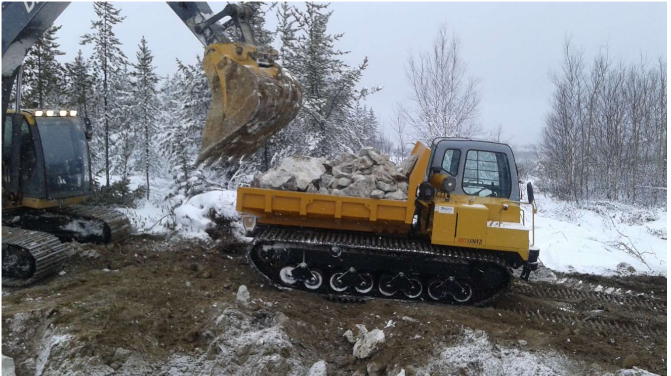
Échantillonnage en vrac pour les travaux de l'usine pilote
