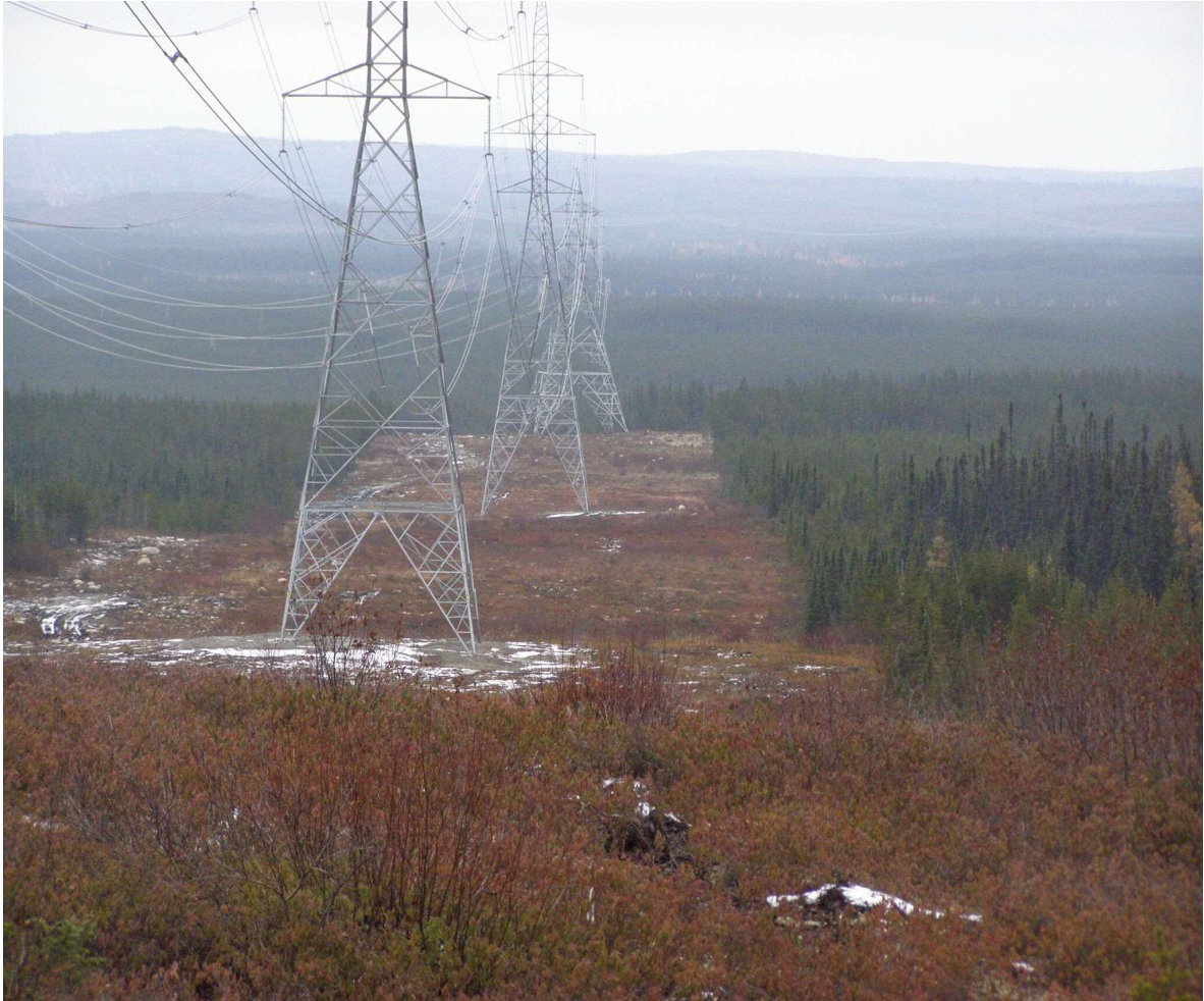
Ligne électrique au site Rose lithium-tantale
